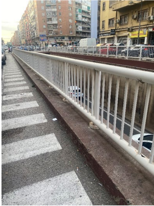
Il·lustració 9. Coronación de los muros.
