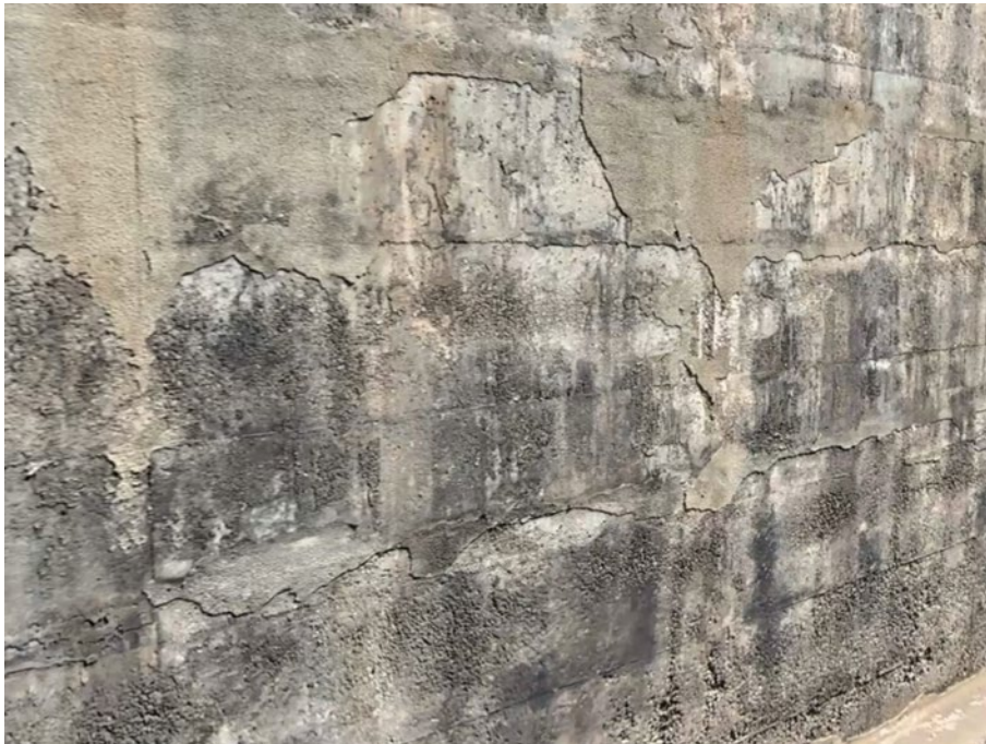
Ilustración 16. Paramento del muro desnudo.
