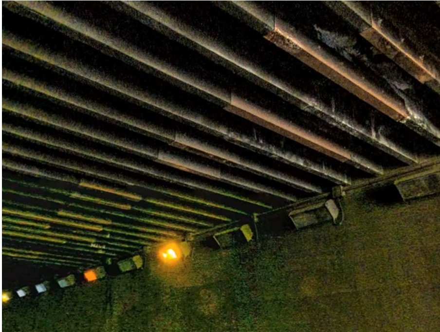
Ilustración 19. Vigas reparadas en el tablero superior bajo Avda. del Cid.
